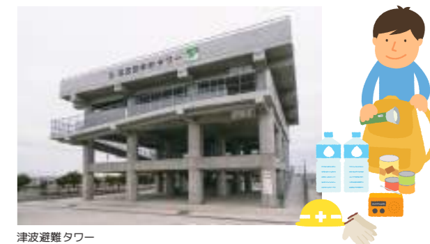
津波避難タワー
